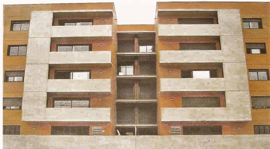
Imagen de la fachada del edificio de VPO en Granollers, hecho con paneles de hormigón
