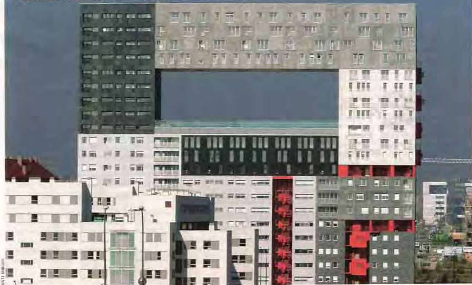
VIVIENDAS EN SANCHINARRO (MADRID) / 2002-2004 / MVRDV, BLANCA LLEÓ
