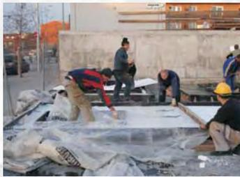
7. Colocación de la capa de polietil antihumedad
