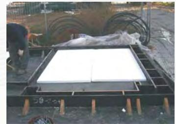
6. Colocación de capa de porexpan
