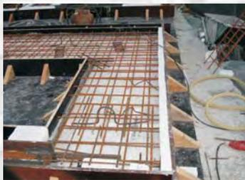
10. Colocación de omegas de montaje
