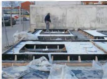
8. Colocación de trabas metálicas
