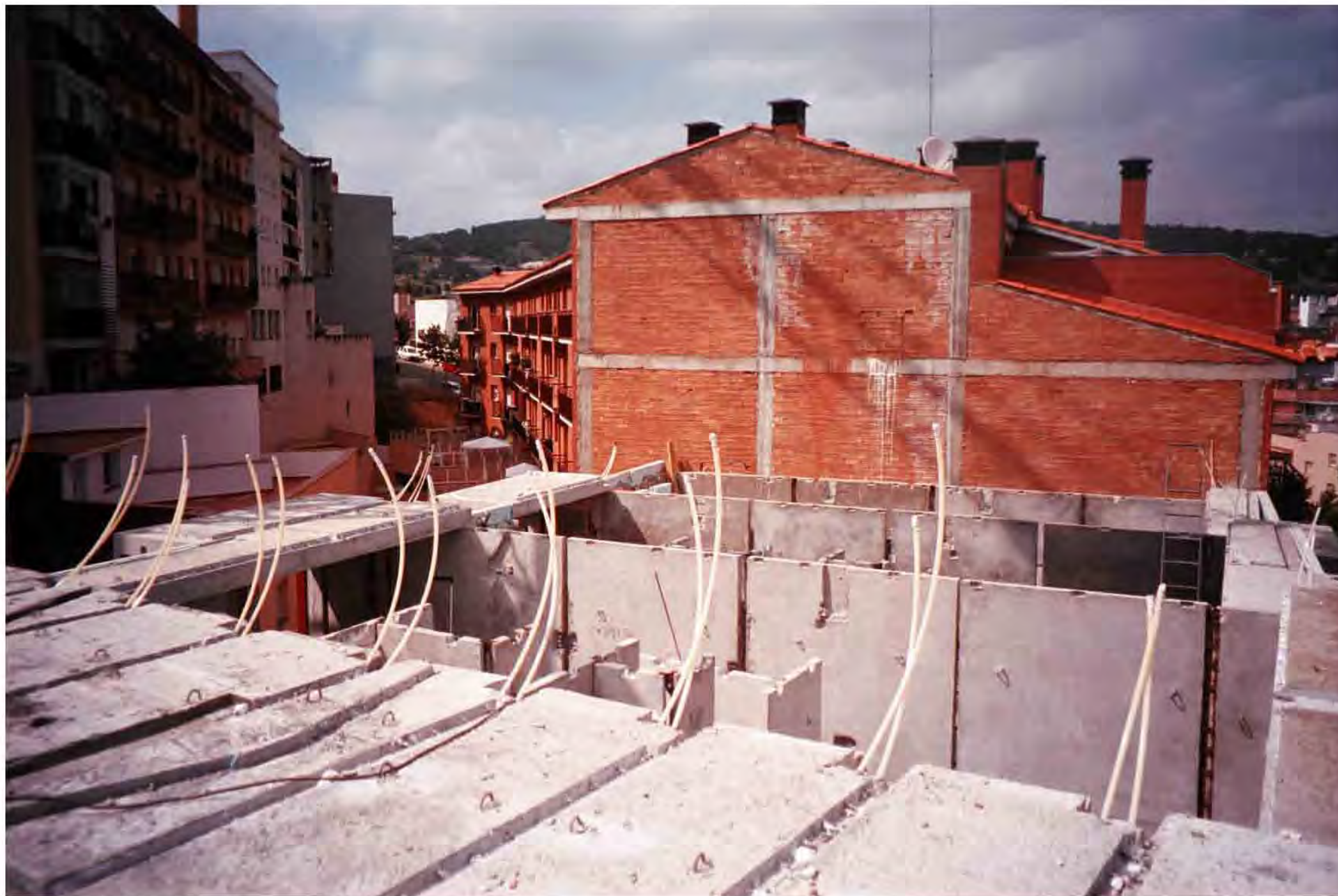
PROCÉS D'INDUSTRIALITZACIÓ – MUNTATGE DE PECES DE FORJAT
