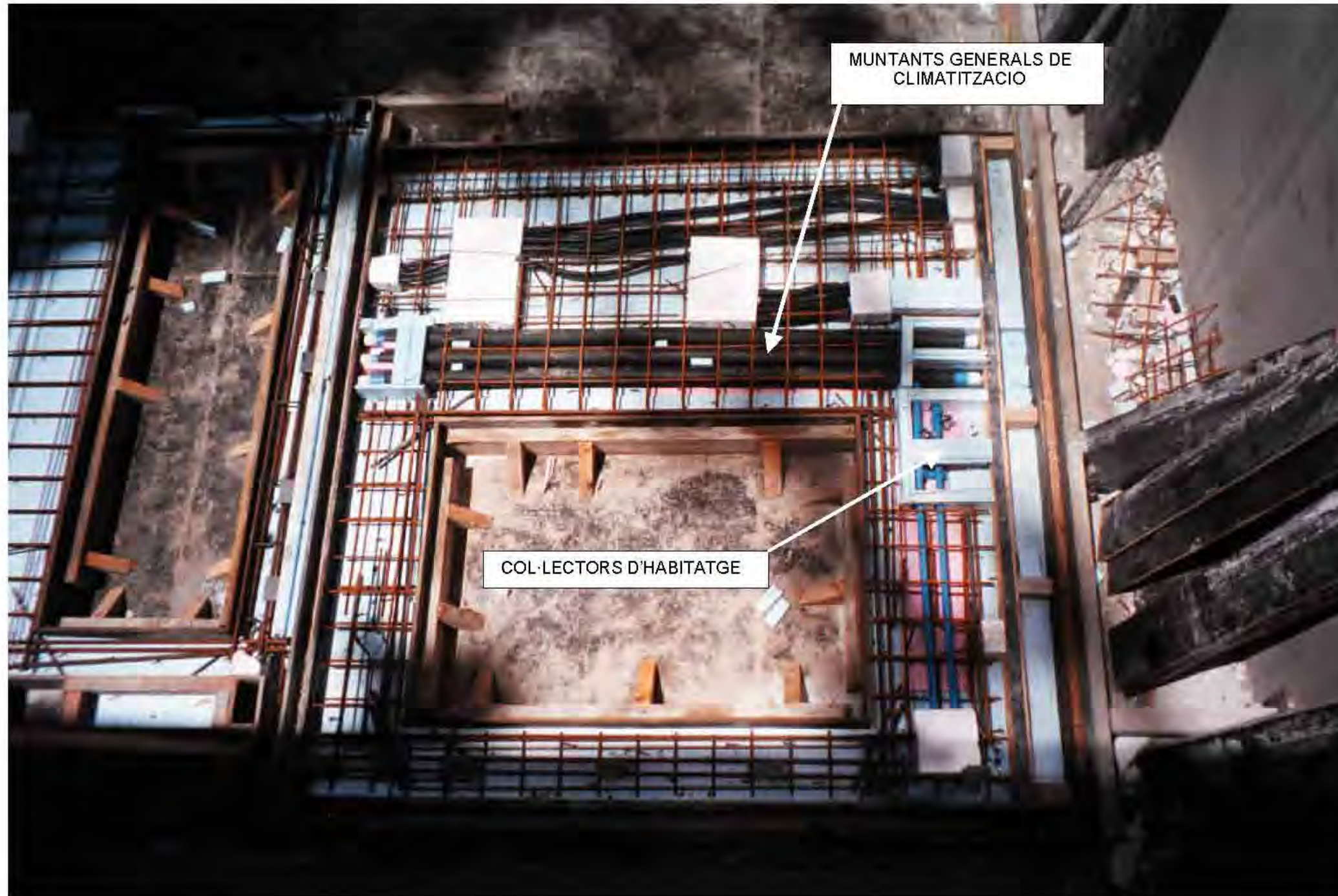
PROCÉS D'INDUSTRIALITZACIÓ – FABRICACIÓ PEÇA DE FAÇANA
