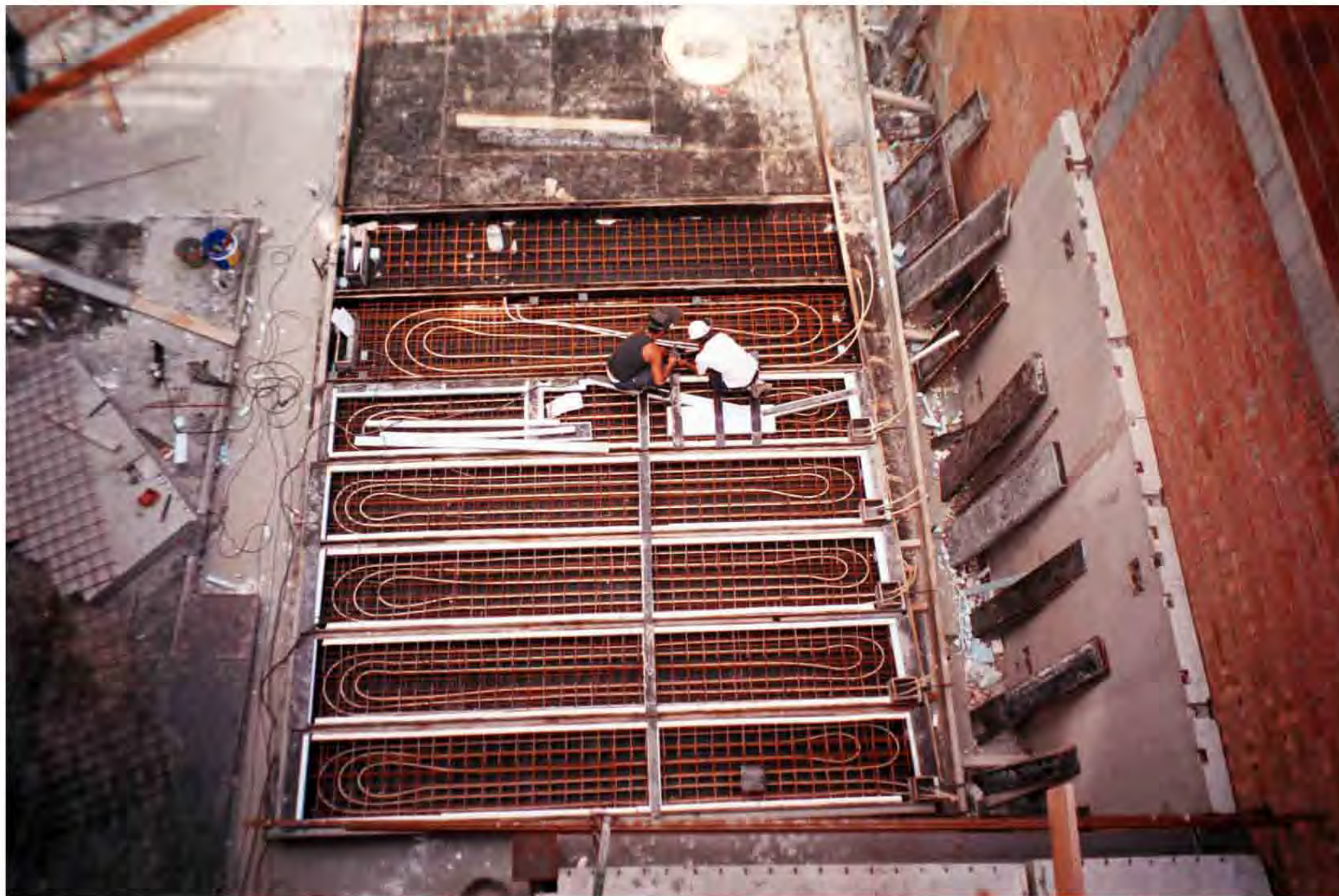
PROCÉS D'INDUSTRIALITZACIÓ – FABRICACIÓ DE PECES DE FORJAT
